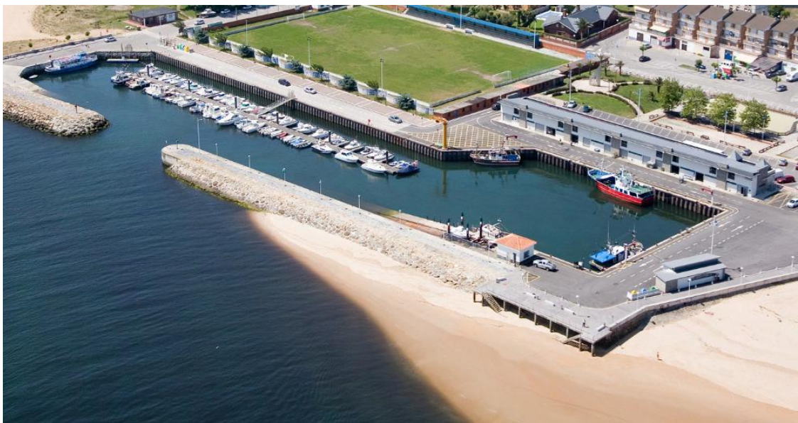
Vista aérea actual del puerto de Suances. Fuente: Servicio de Puertos. Gobierno de Cantabria.
