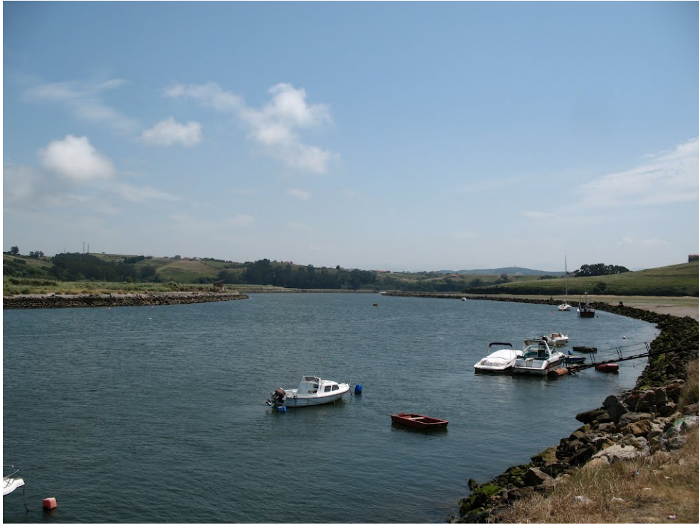
Tramo pk 20: estado actual de la escollera.
