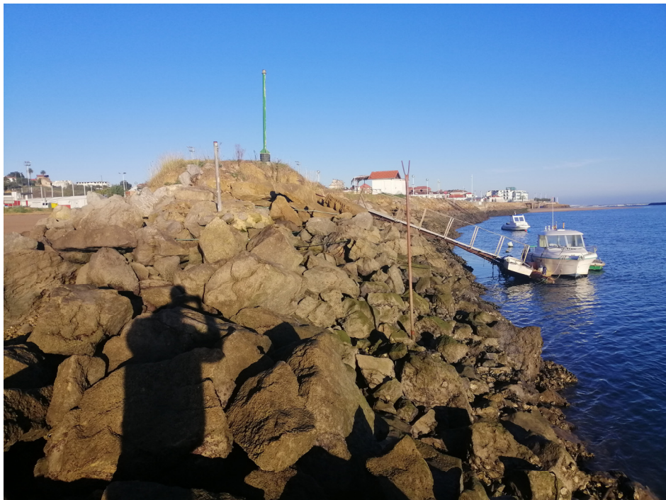
Pk 70: parte final de la escollera existente a la cota +6,00 m.
