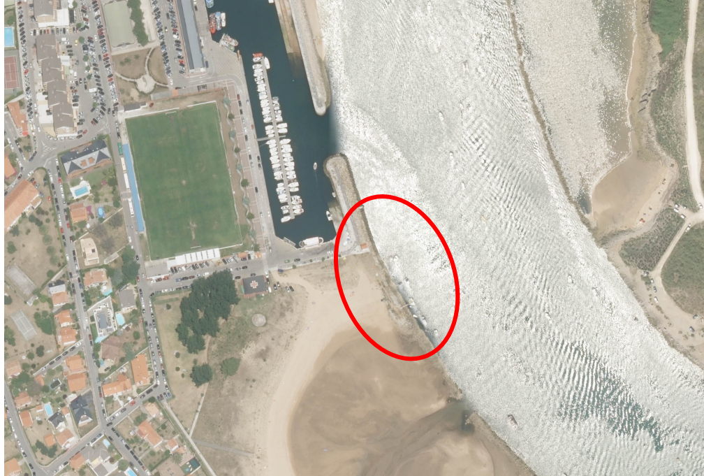
Vista aérea de la zona de la ría donde se ubicará el museo
