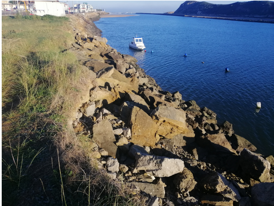
Tramo pk 00: estado actual de la escollera.
