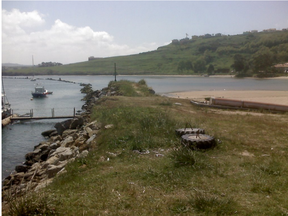
Vista de la zona de muelle desde el punto de acceso al paseo
